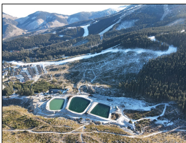
Obr. č 2 vodné nádrže - Jasná
