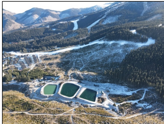
Obr. č 2 vodné nádrže – Jasná
